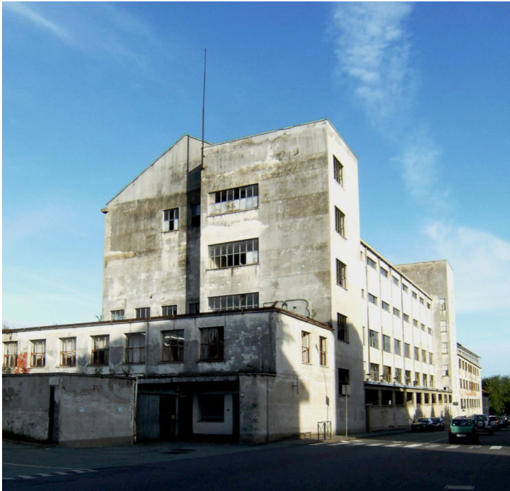
Figura 7. Ex Pettinature Riunite Rivetti. Edificio proyectado por el arquitecto Giuseppe Pagano-Pogatschnig -1939-41-. Vista del Edificio Pagano. Autora: Cristina Natoli.
