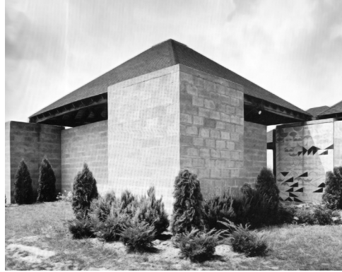
Figura 9. Acceso a la Casa de Baños, con el mural de Marie Kwo marcando la entrada por el lateral del primer módulo (fotografía de John Ebstel, Progressive Architecture , 1984, 12: 69).
