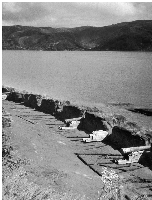
Figura 9. Bateria luego del trabajo de despeje y el emplazamiento antiguo de los cañones descubierto. Autor R. Montandon. c.1954. Fuente: (Montandon, 2001 [1972]: 280).
