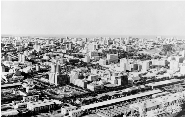
Figura 2. Vista aérea de la ciudad de Maputo (ex Lourenço Marques) a finales de los años 1960. Archivo Histórico Ultramarino, IICT/ACTD/AHUD16359.
