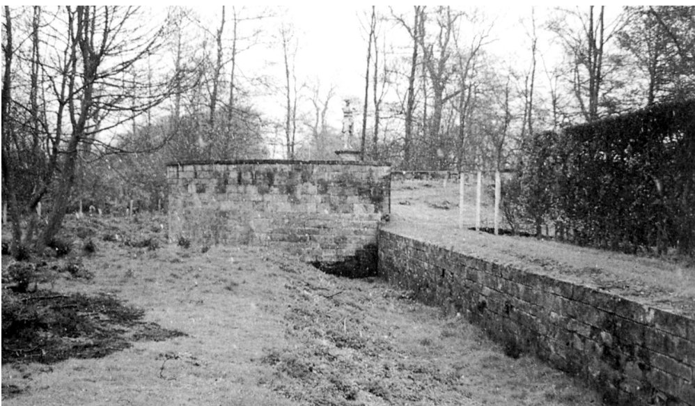
Figura 15. Seaton Delaval. Fotografía del encuentro del ha-ha con uno de los bastiones circulares del perímetro (Williams y Ridgway 2000:61). Seaton Delaval Hall, viewed from north-west
