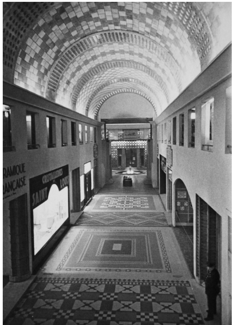
Figura 17: Galería de Manufacture de Sèvres Detalle de bóveda y pavimentos.
