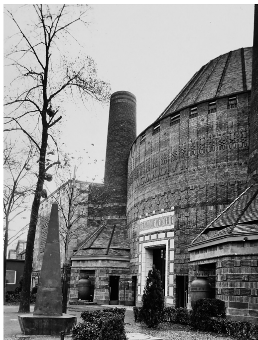
Figura 11: Entrada por el cuerpo cilíndrico. Detalle de letrero y del aparejo del ladrillo.
