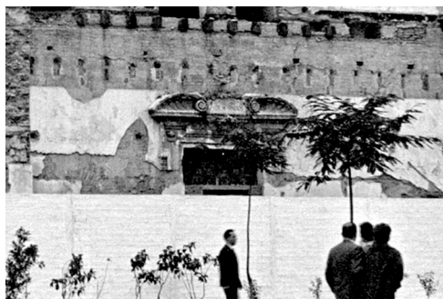
Figura 11. Remate original de la puerta de entrada a la iglesia que quedó tras el derribo, y que Hernández respetó en el diseño de la portada. Fuente: © ICAS-SAHP. Fototeca Municipal de Sevilla. Fondo Cubiles (detalle). Capilla de San Hermenegildo en obras. Exterior. 09-1960.
