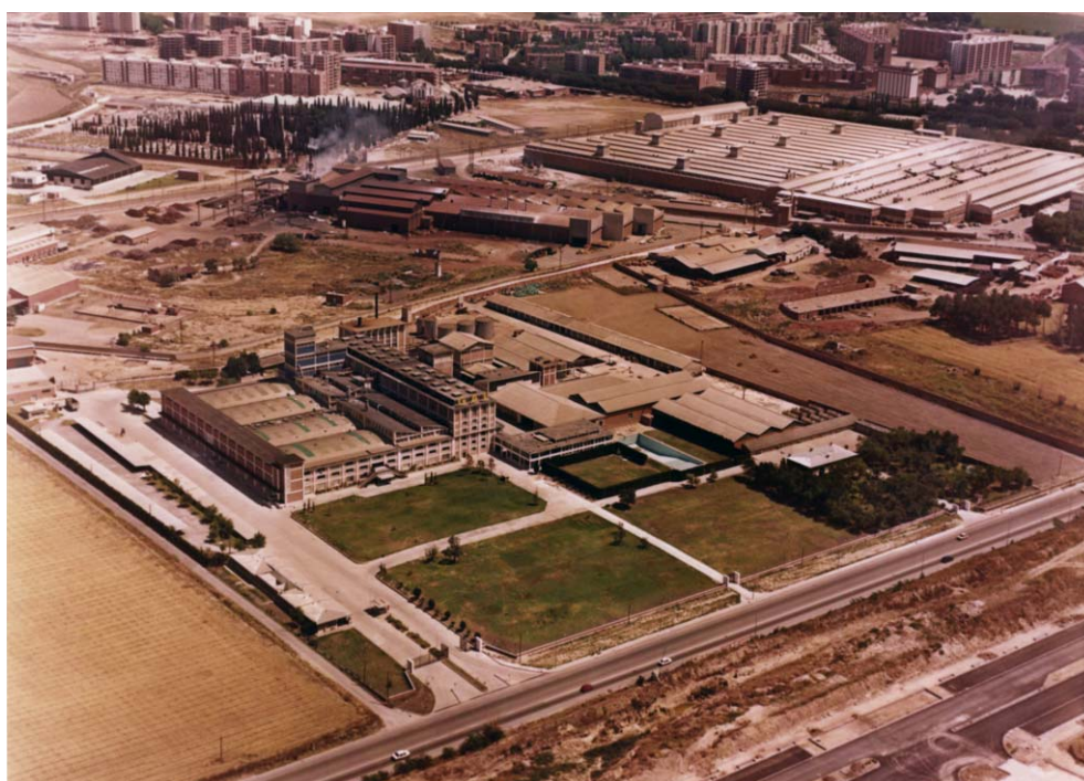
Figura 13. Vista aérea de las fábricas GAL y Roca. 1977 (FOAT Madrid S.L.)
