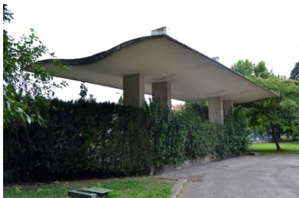
Figura 19. Fábrica Roca. Marquesina frente al acceso principal por Vía Complutense (Fotografías autora).
