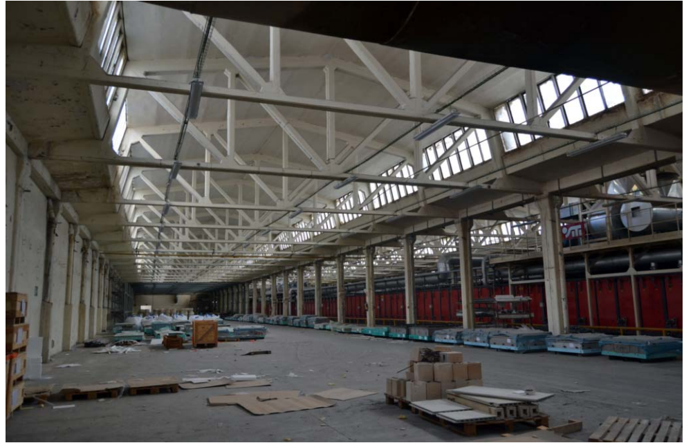
Figura 23. Interior antigua nave de producción de porcelana sanitaria (Fotografías autora).
