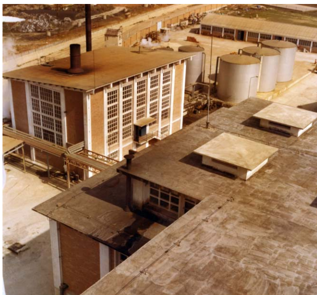
Figura 34. Fábrica de Perfumería GAL. Vista de la Central Térmica y de los almacenes desde la cubierta de la nave de calderas (Fotografía Pando).
