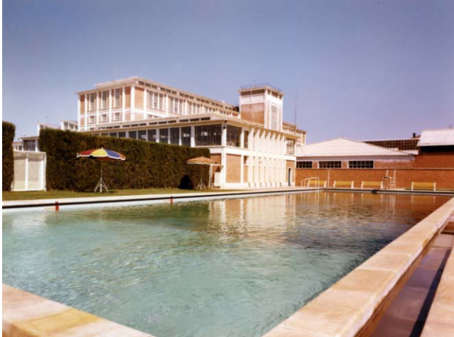
Figura 10. Fábrica de Perfumería GAL. Vista de la piscina y edificio social (comedores y vestuarios) (Archivo de empresa GAL).
