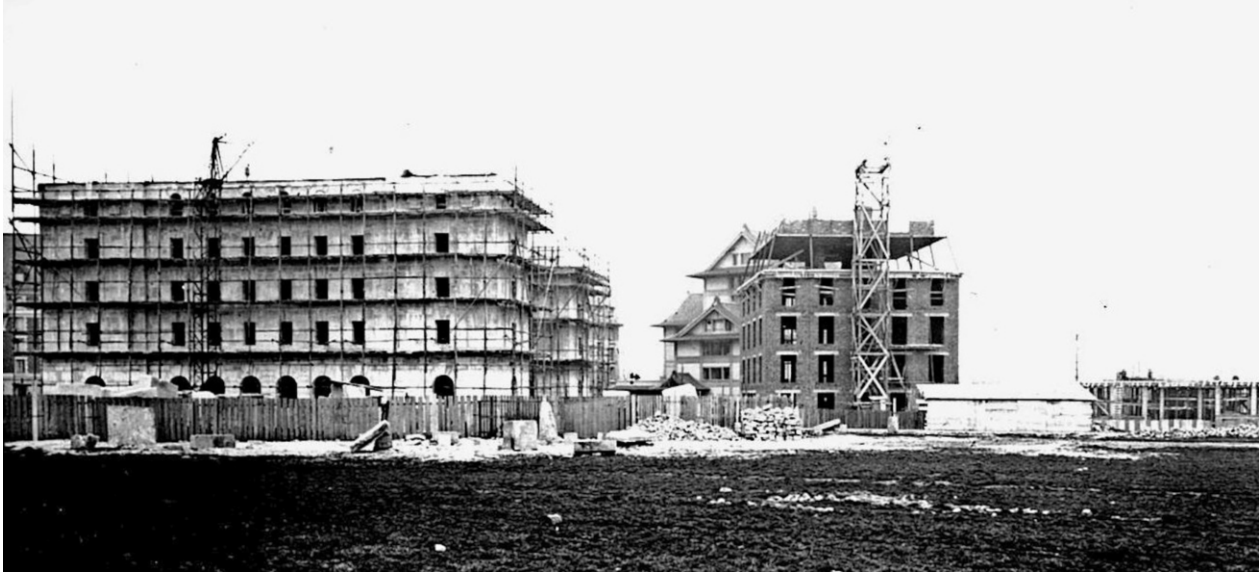
Figura 19. Colegio, foto de obra, mostrando sistema constructivo (archivo ACE).
