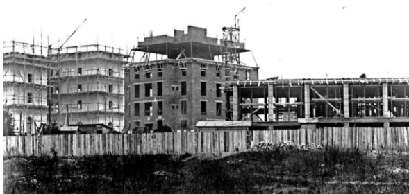
Figura 22. Colegio y Pabellón, procesos constructivos, fotos de obra (archivo ACE).
