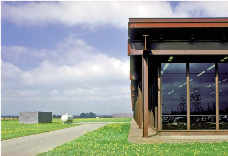
Detalle de esquina y visión frontal de los vidrios del cerramiento. KRJDA.
