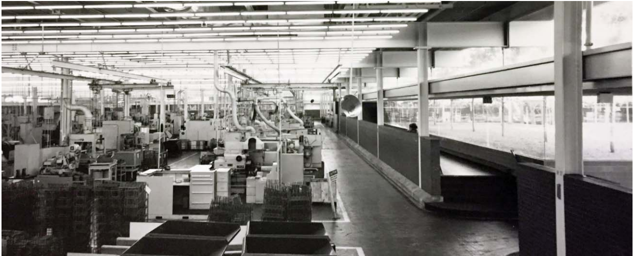
Imagen de época del interior de la fábrica con la maquinaria ya instalada. A la derecha, el patio central que conecta con la zona de trabajo. KRJDA.
