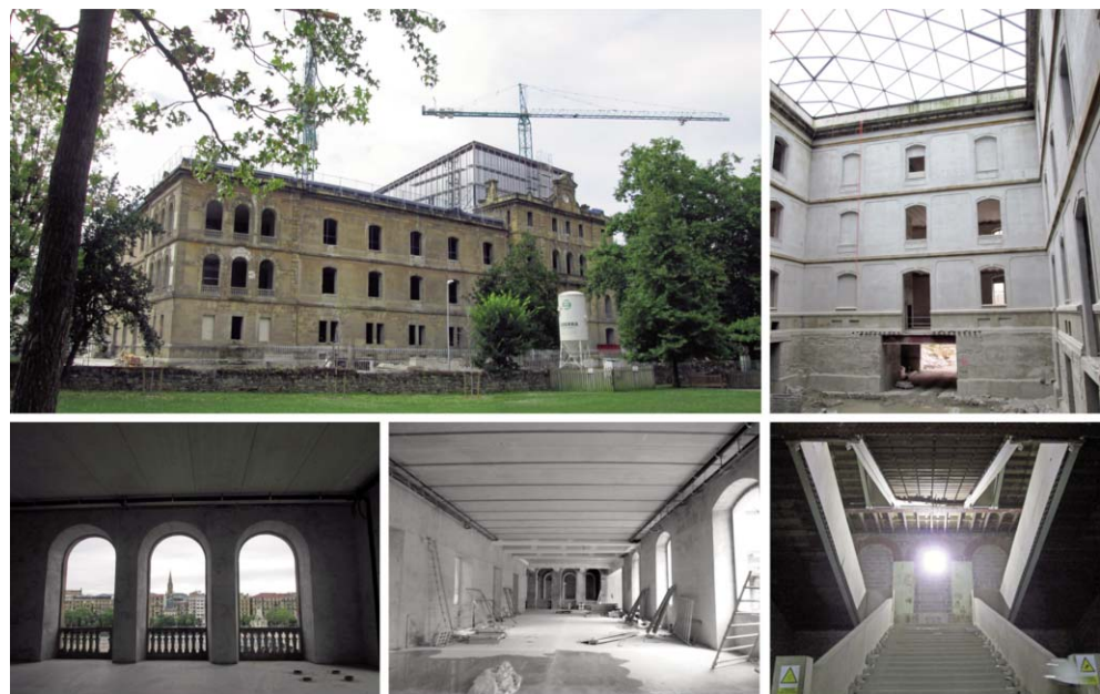
Vistas de la fachada principal, patio noroeste, estancias interiores y escalera principal de la Fábrica de Tabacos de San Sebastián durante las obras de recuperación del inmueble para uso cultural (Fotógrafo: Carolina Castañeda, 2014).
