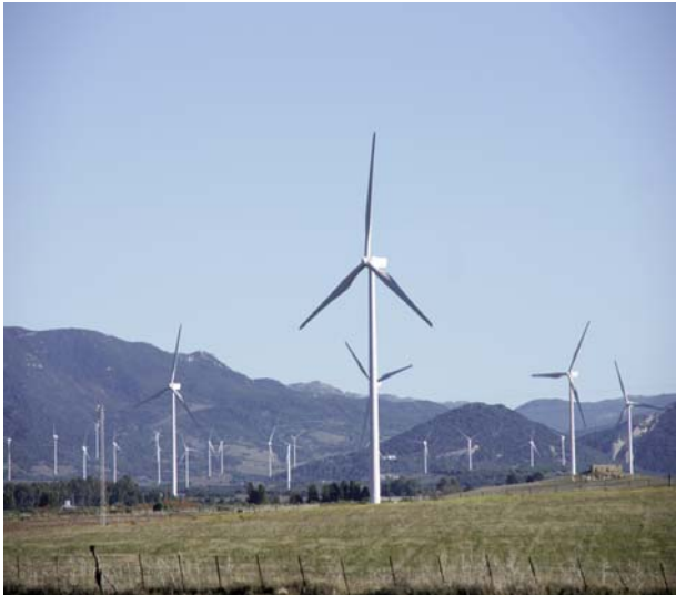
Izquierda. Figura 34. Parque eólico de Facinas (Cádiz). Fuente: autores.
