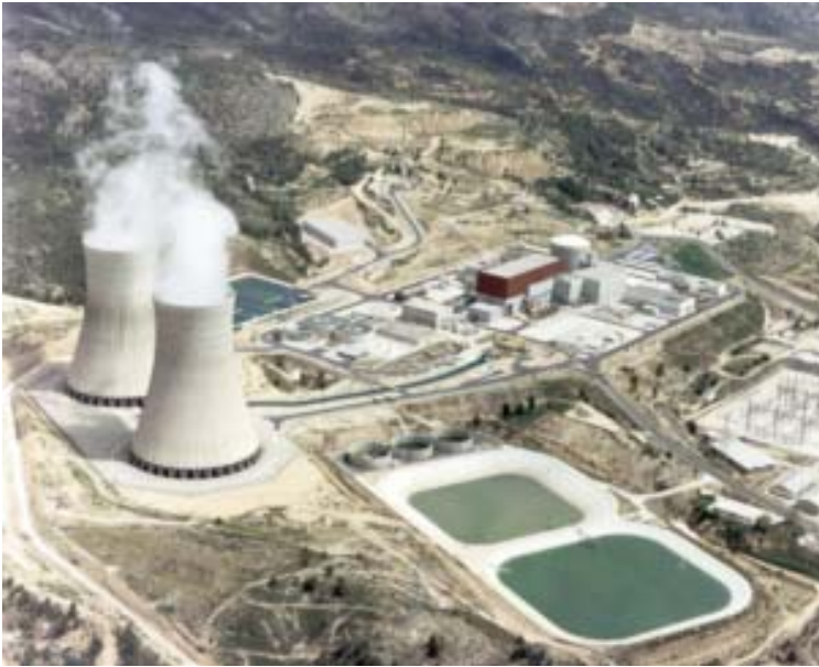
Figura 28. Torres de refrigeración de la central nuclear de Cofrentes, Valencia. Fuente: ref. web 20.
