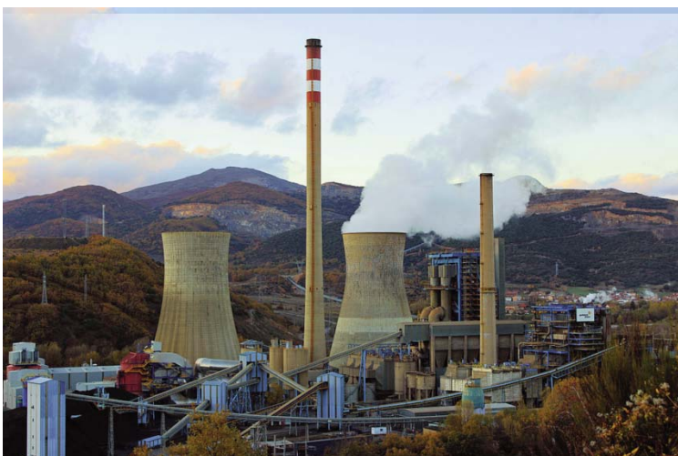
Figura 27. Central térmica de La Robla (León). Fuente: ref. web 18.
