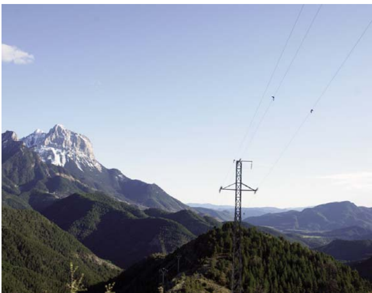
Figura 36. Torre del tendido eléctrico en las cercanías del Parque Nacional de Ordesa y Monte Perdido (Huesca). Fuente: Autores.
