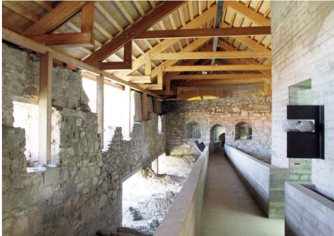
Figura 31. Hamar, rampa en el ala central. Autor
