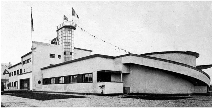
Exterior del Aeropuerto del Lido, Venecia. (L'Architecture d'aujourd'Hui. 1936. nº9)
