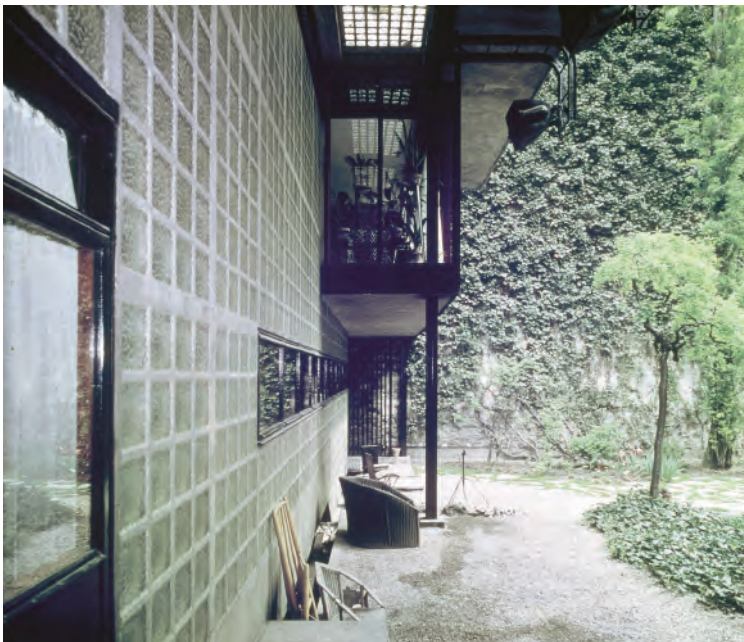
Maison de Verre, parte de la fachada. (Foto Honings, archi- vo autor)
