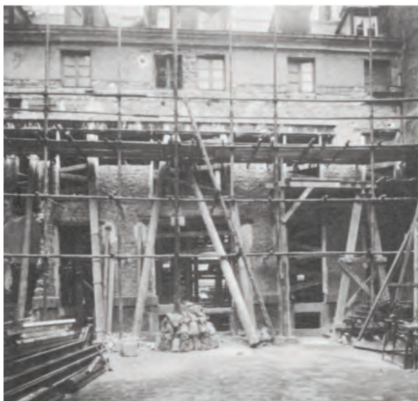
La Maison de Verre en construcción, foto en Perspecta.
