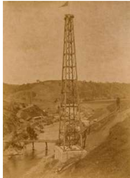
Figura 5. Construcción de las torres sobre las pilas del viaducto Malleco, 1888.
