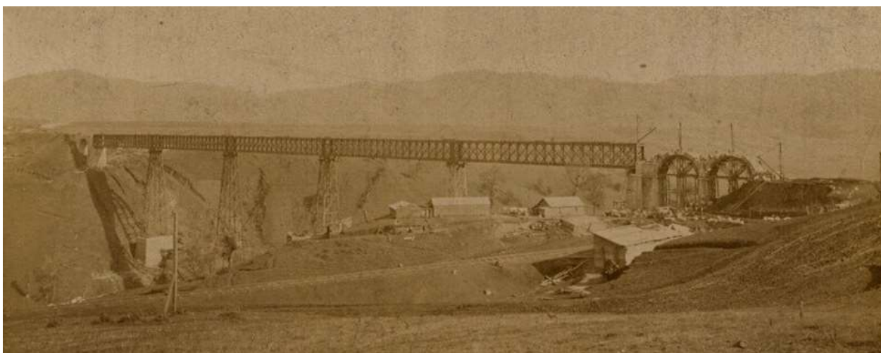
Figura 20. Viga armada sobre las cuatro pilas, 1 bóveda en el sur y 2 en el norte 1890. Fuente: http://www.bibliotecanacionaldigital.gob.cl/bnd/632/w3-article-331354.html
