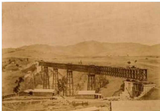
Figura 9. Viga armada sobre las cuatro pilas, 1890 Fuente: http://www.bibliotecanacionaldigital.gob.cl/bnd/632/w3-article-316165.html
