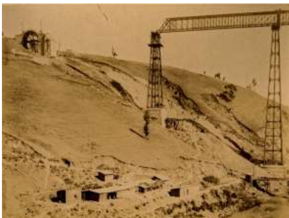
Figura 8. Extremo sur de la viga armada, 1890 Fuente: http://www.bibliotecanacionaldigital.gob.cl/bnd/632/w3-article-316161.html
