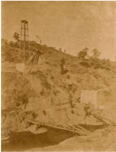
Figura 4. Construcción de las pilas del viaducto Malleco, 1886-1887.
