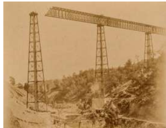
figura 7. Lanzamiento de la viga armada, 1890
