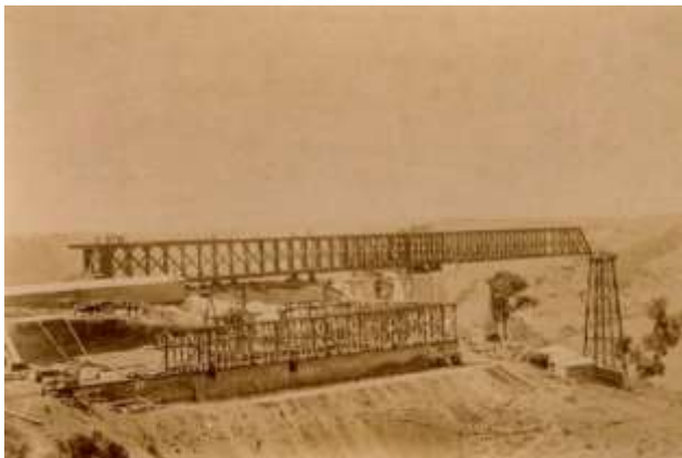
Figura 6. Estribo norte, viga armada del viaducto Malleco, 1890.
