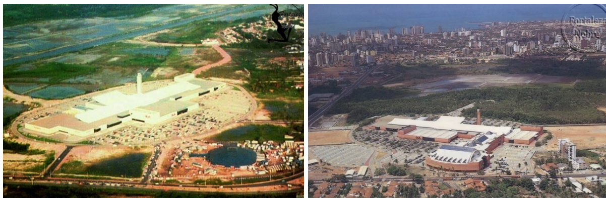
Figura 35 - Início da construção do Shopping na área das salinas (esq.) e Shopping já instalado com mangue das antigas salinas em início de recuperação ao fundo (dir.).
