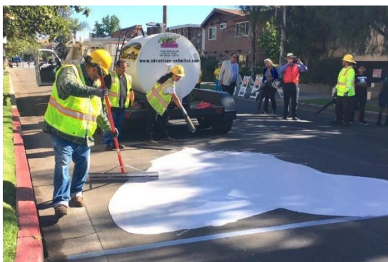
Figura 27. Transformación urbana con pavimentación fría en Los Ángeles (7010 Jordan Av.) Fuente: Los Angeles Street Services (mayo, 2017).
