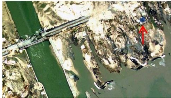
Figura 8. Ubicación de la vivienda antes y después del Huracán Ike. Obsérvese el nivel de destrucción acaecido en la franja costera de la Península Bolívar en el Condado de Galveston, Texas.
