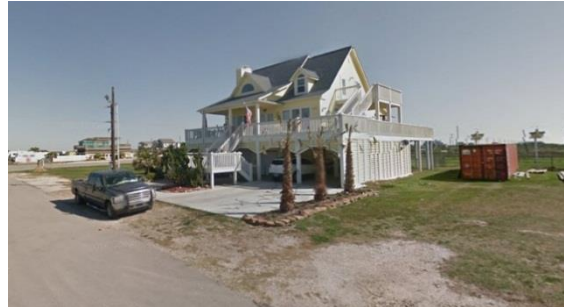
Figura 9. La vivienda una vez rehabilitada. Reconstruida tras el huracán Rita en 2005 sus propietarios elevaron la vivienda a una cota superior a la anterior siguiendo lo establecido en las nuevas ordenanzas de edificación. Fuente: Google Street View.
