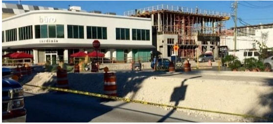
Figura 1. Obras de elevación de calle en Sunset Harbour Dr., Miami Beach . El aumento de la cota superficial de las calles ha modificado sustancialmente la fisonomía de la ciudad, dejando numerosos inmuebles a niveles inferiores a la rasante de la acera principal.
