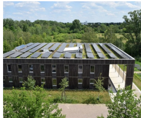
Imagen 54. Cubierta de UBA 2019. Fuente: BuGG.
