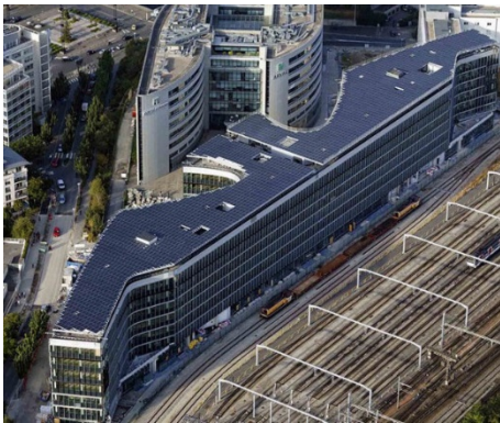
Imagen 41. Cubierta de Green Office Rueil. Fuente: Bouygues Immobilier
