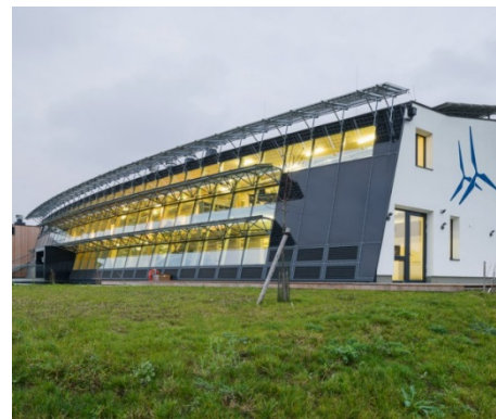
Imagen 36. Fachada de Windkraft Simonsfeld AG.
