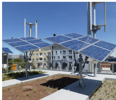
Imagen 50. Cubierta de Pixel building.
