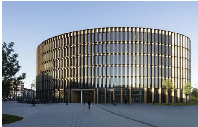
Imagen 14. El Ayuntamiento de Friburgo, Alemania, se presentó en 2018 como el primer edificio público del mundo capaz de producir más energía de la que consume. Autor: Ingenhoven architects / HGEsch Fuente: https://www.floornature.es/ingenhoven-architects-freiburg-town-hall-freiburgo-14259/
