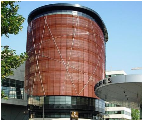
Imagen 47. Fachada de Elithis tower. Fuente: Alchemica/wikipedia
