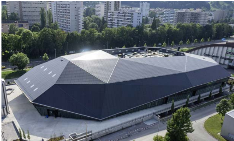
Imagen 60. Imagen aérea del Umweltarena Spreitenbach, Suiza. Fuente: René Schmid Architekten en colaboración con Umweltarena Schweiz.
