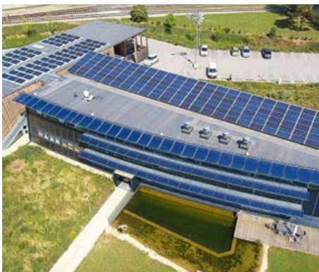
Imagen 35. Cubierta de Windkraft Simonsfeld AG.
