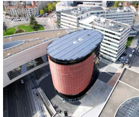
Imagen 48. Cubierta de Elithis tower. Fuente: Alchemica/wikipedia
