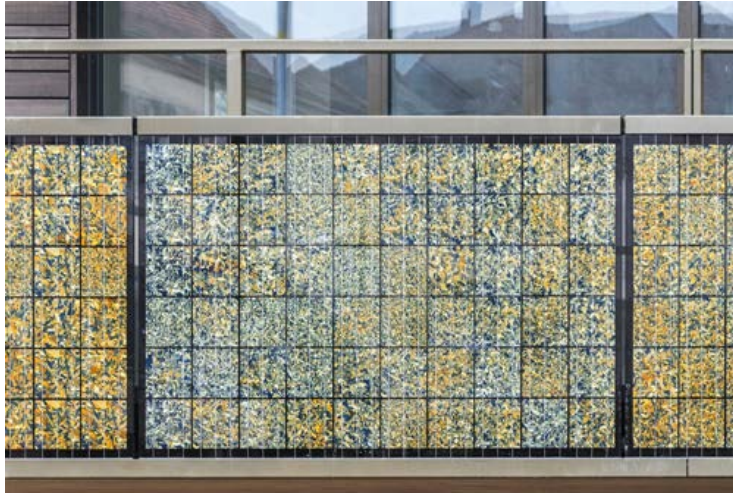
Imagen 58. Los paneles solares fotovoltaicos están desarrollando multitud de posibilidades estéticas para su integración como elementos constructivos en la envolvente arquitectónica. Frentes de balcones de un edificio en Altstetten.
