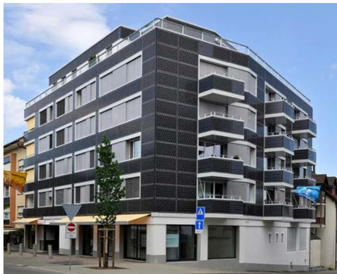
Imagen 15. El concepto PEB también aplica a edificios existentes, como esta renovación y ampliación de un edificio en Alleestrasse Romanshorn, Zurich, que destaca por su diseño que incorpora elementos captadores fotovoltaicos tanto en la fachada como en la cubierta. Fue el proyecto ganador del Premio Norman Foster Solar Awards 2013. Arquitectos autores: Viridén-Partner AG.
