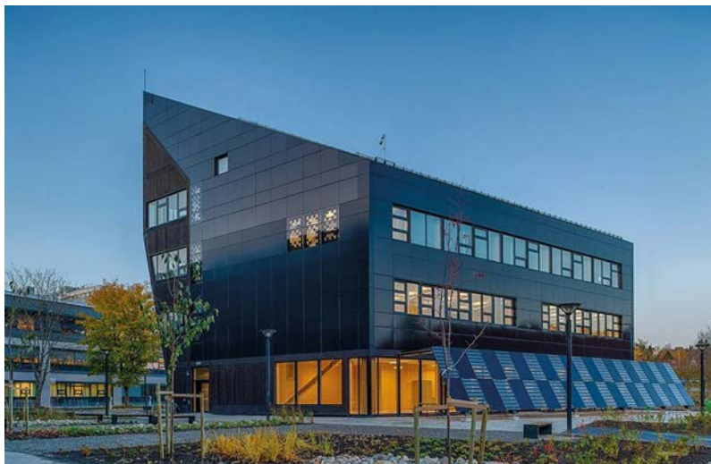
Imagen 55. Edificio Laboratorio ZEB con sistema de captación solar fotovoltaica en fachada y cubierta, una colaboración entre NTNU y Sintef, en Trondheim, Noruega.
