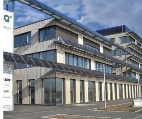
Imagen 34. Vista lateral de la fachada. Centro Tecnológico de Aspern IQ.
