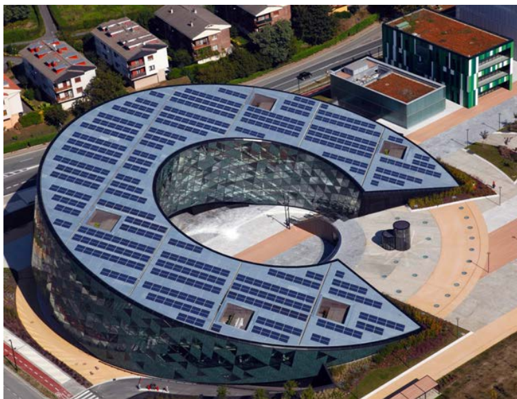
Imagen 21. Vista aérea del Edificio Zero mostrando su cubierta inclinada 15° y las placas solares fotovoltaicas integradas.
