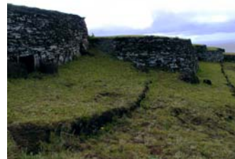
Figura 12. Vista de las viviendas.
