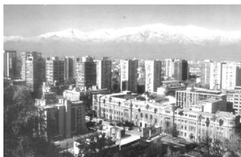
Fig. 10. Vista de la Remodelación San Borja. Fte.: AUCA N°17, Santiago, 1970.
