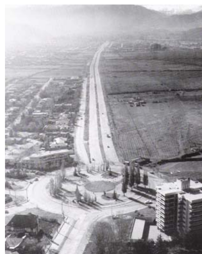
Fig.40. Avda. Kennedy en construcción, a la altura de A. Vespucio, (vista al oriente). Fte.: Album copia: CHILE, M.O.P., D.G.O.P. Transporte Metropolitano- Metròpoli de Santiago - septiembre de 1970 - Infraestructura Urbana del desarrollo Económico y Social 2. Inédito en Archivo de J. PARROCHIA, 2005.
