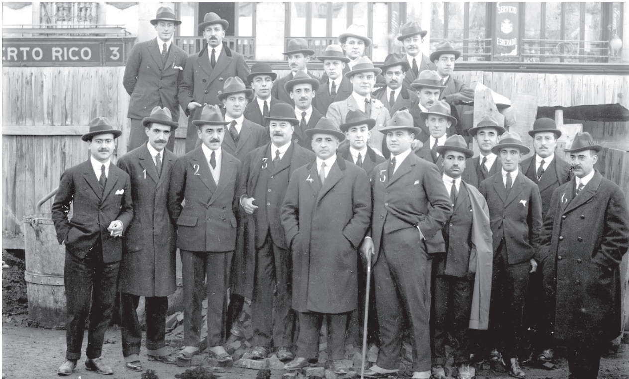
Figura 1. Los alumnos de la Escuela Superior de Arquitectura de Madrid visitan las obras del Metropolitano de Madrid acompañados de los profesores Manuel Martínez Ángel (3), César Cort (5) y Carlos Grasset (6), con los directores de éstas, los hermanos Joaquín y Juan Otamendi Machimbarrena (1 y 2) y Antonio Palacios (4), en diciembre de 1919. “Una visita a las obras del Metropolitano”, ABC, Madrid, 4 de diciembre de 1918.
