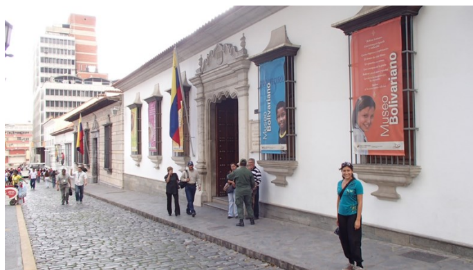
Figura 8: Estado actual del casco colonial de Caracas.
