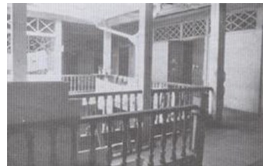
Fig. 17 Imagen de los dormitorios del edificio
