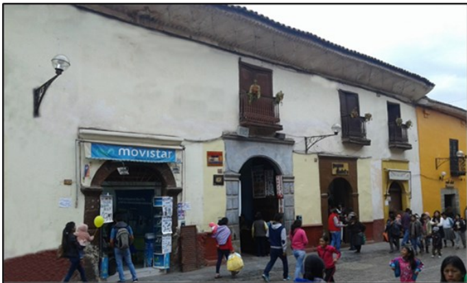
Imagen 3. Fachada Jirón 28 de Julio. Fuente: Propia.
