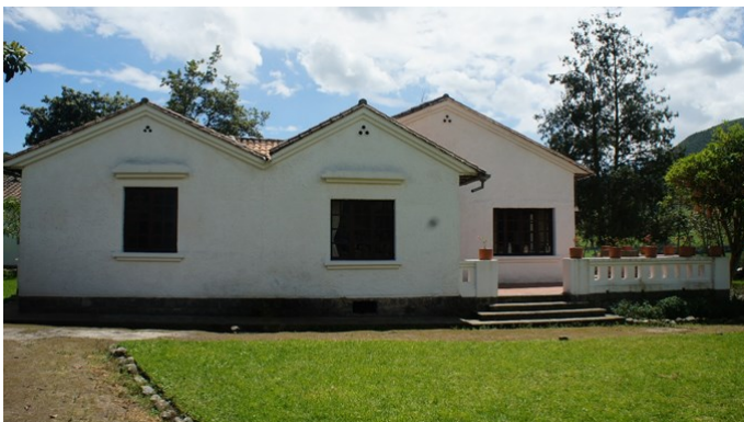
Fig. 20. Fachada Lateral Izquierda.
