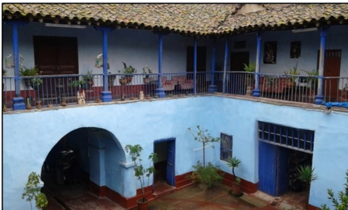
Imagen 4. Vista interior galería norte. Fuente: Propia.
