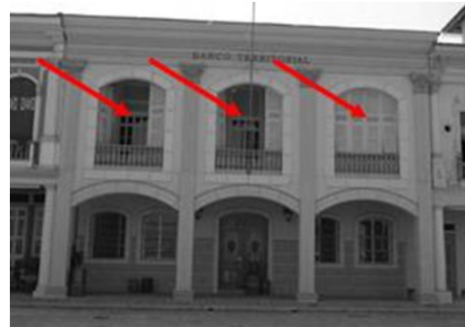
Fig. 16 Imagen de la galería central del edificio
