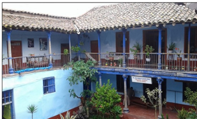
Imagen 10. Cubierta inclinada. Fuente: Propia.
