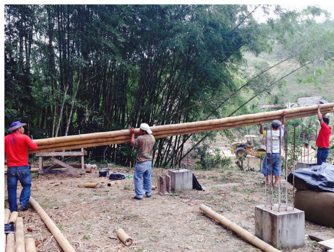
Fig. 9. Imagen de construcción de la cimentación de la vivienda. Tomado de Vivienda costa ecuatoriana [7]
