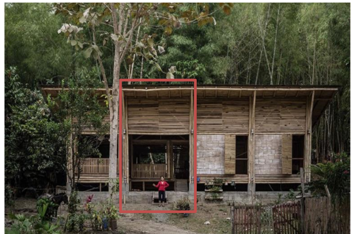
Fig. 13. Fachada frontal, ingreso principal. Tomado de Vivienda vernácula de bambú [6]
