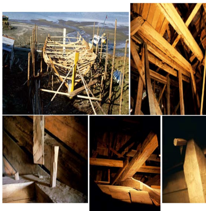
Fig. 8. Construcción en madera Chiloé [4]
