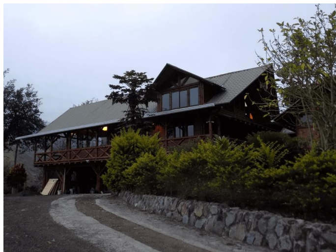
Fig. 30. Fachada frontal vivienda de bambú. Tomado de Vivienda tipo I de bambú [9]
