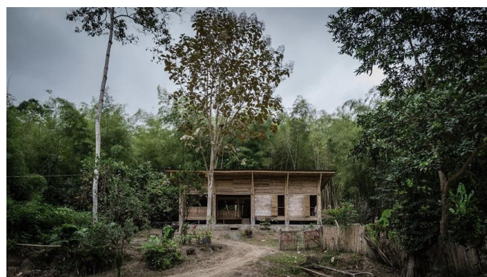
Fig. 5. Vivienda de bambú Tomado de Vivienda vernácula de bambú [6]
