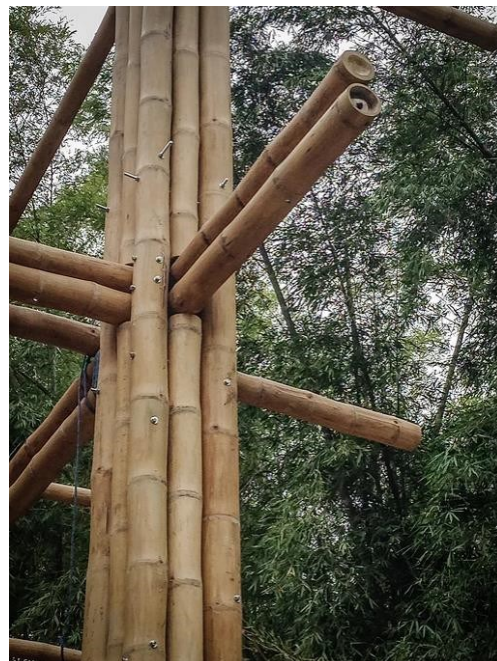
Fig. 8. Detalle de la unión columna – viga. Tomado de Vivienda costa ecuatoriana [7]
