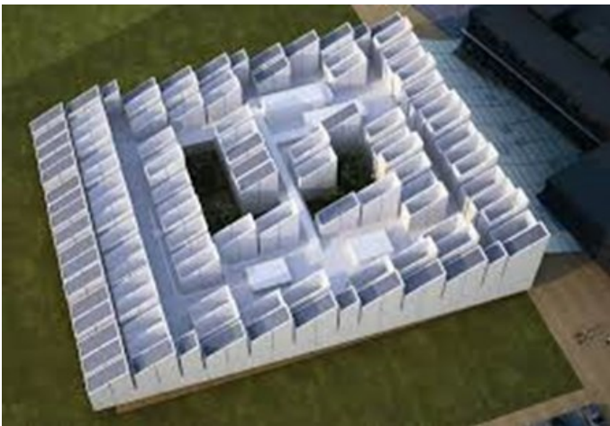
Fig. 12. Particular de la "cobertura a chimeneas" desfondada al centro para crear un corral-jardín; el espacio vidriado, destinado a los todas las funciones públicas del complejo, además de señalar la entrada al complejo, suple de interconexión entre el edificio existente, negro, y aquel nuevo. (Fuente: MCArchitects, https://www.mcarchitects.it/ ultima fecha: 28/05/2018)
