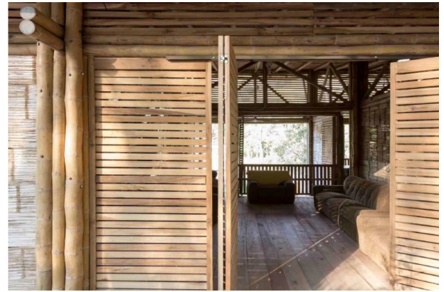
Fig. 15. Detalle de persianas. Tomado de Vivienda vernácula de bambú [6]
