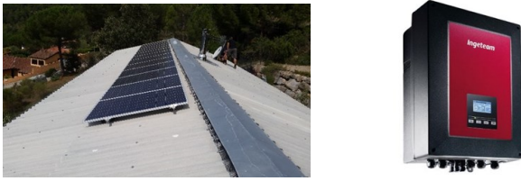
Fig. 3. (a) Vista del generador fotovoltaico de 3,18 kWp y (b) Inversor de 3kW.
