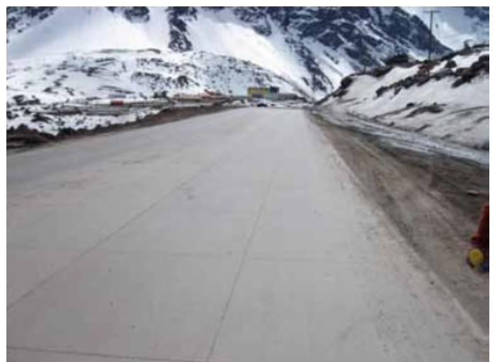
Fig. 12. Fotografía de Pavimento de losa corta de 15 cm de espesor con fibra incorporada. Ruta N°60 que conecta los Andes de Chile con Mendoza, Argentina. Fuente: [1].
