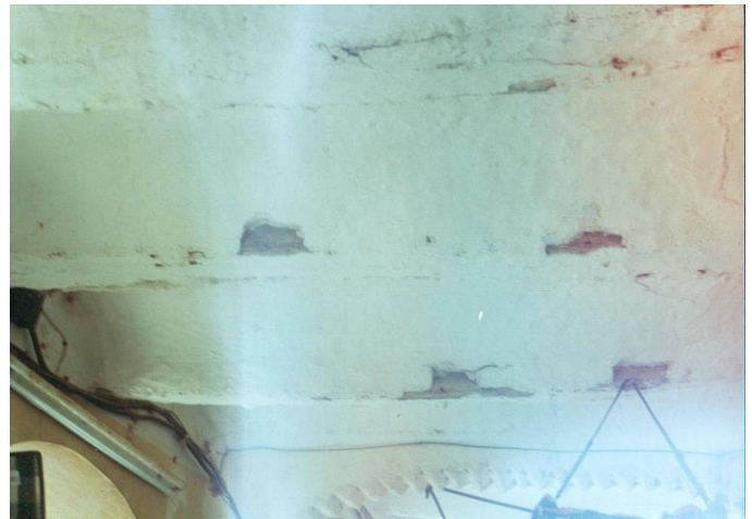
Figura 10: Revestimiento de techo con yeso (Fuente: exposé du mزاب)
