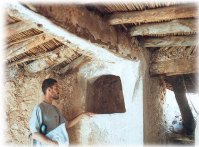
Figura 12: Vigas en madera de palma (Exposé du mzab)
