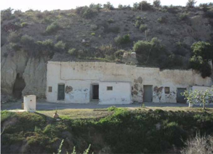
Figura 15: Fachada principal con las dos puertas de acceso existentes. Fotografía realizada por el autor.
