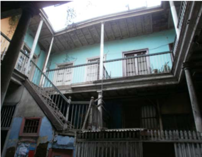
Figura 11: Patio Interior y escalera. Fotografía tomada por Sandra Olmos, Fanny Centeno, Erika Ampuero y Lily Campos para la asignatura Restauración de Monumentos- UNFV.
