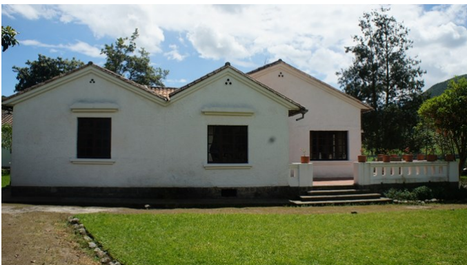
Fig. 20. Fachada Lateral Izquierda.
