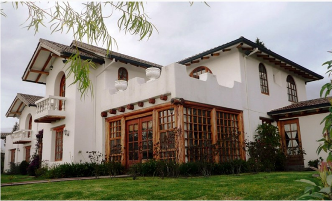
Fig. 23. Vivienda de Adobe Made [7].
