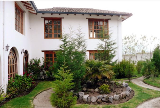
Fig. 24. Vivienda de Adobe Made [7].
