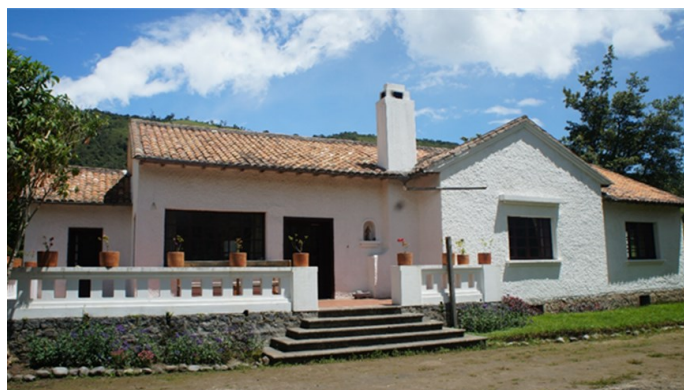
Fig. 10. Vista Frontal Casa de Hacienda.
