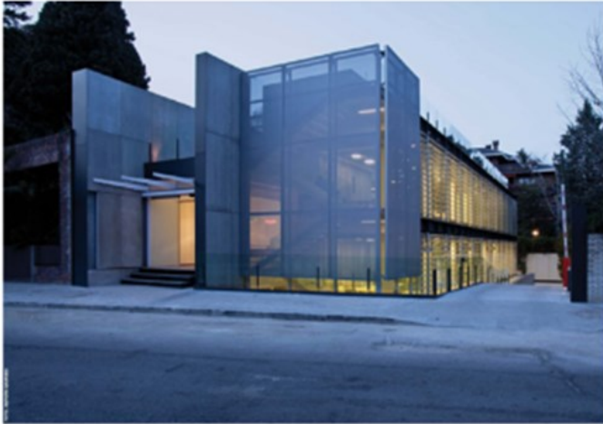
Fig. 1. Edificio en la calle Apolonio Morales, 29.
