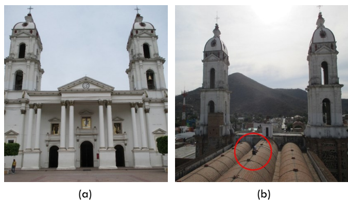
Fig. 8. Obtención de frecuencias naturales con acelerómetros: (a) vista general de una iglesia en Tlajomulco y (b) medición de vibración ambiental a nivel de bóvedas.
