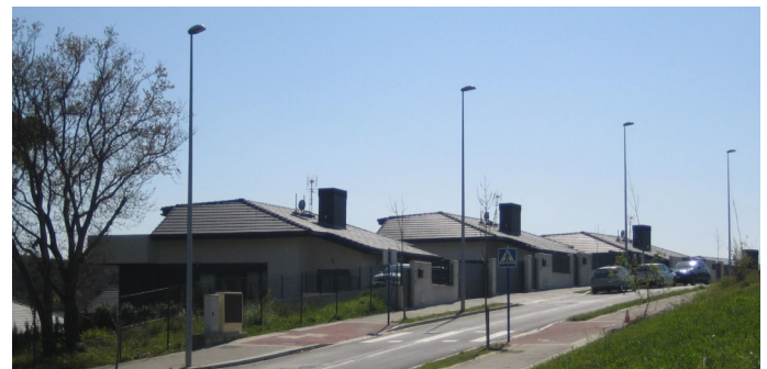
Figura 6: Vista desde Noreste (fuente: ELR)
