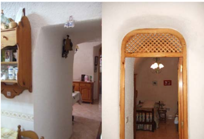
Figura 16: Detalle de huecos de paso y habitaciones interiores para tener luz natural y ventilación. Fotografía realizada por el autor.
