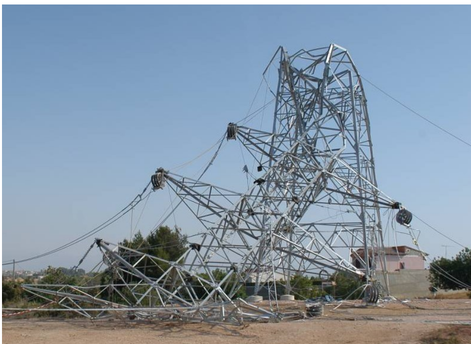
Figura 1: Estado final apoyo celosía tipo siniestrado durante ejecución línea de alta tensión.
