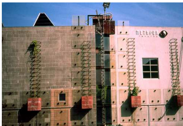
FIGURA 4: Complejo Periférico de Eric Owen Moss próximo a Culver City (Los Angeles)
