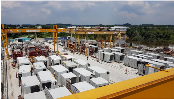
Fig. 8. Modular prefabrication. Source: Fuente Clement Canopy Condo. Singapur
