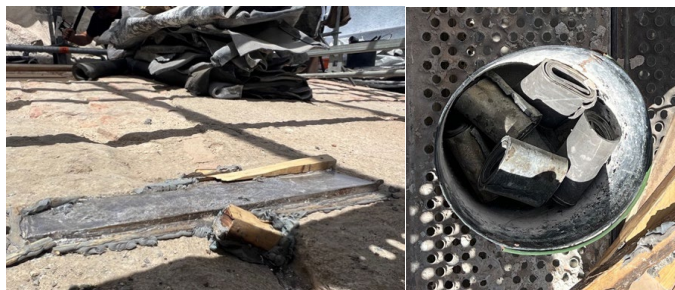
Fig. 2 Detalles de grapa emplomada y acopio de fragmentos de planchas para fundir
