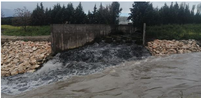
Fig. 1. Vertido directo de aguas urbanas a cauce desde una EDAR (Fuente: Ayto. de Getafe).
