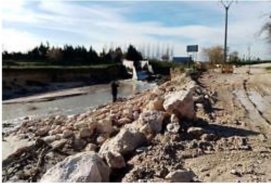
Fig. 5. Obras de emergencia para proteger el camino da3ado y garantizar el acceso desde Getafe (Fuente: Ayto. de Getafe).
