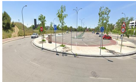
Fig. 2. Ejemplo de aparcamiento cuya construcci3n se vio comprometida ante la imposibilidad de conectarlo con los sistemas de drenaje disponibles. Su viabilidad fue posible gracias a la infiltraci3n de la escorrent3a. (Fuente: Google Maps).
