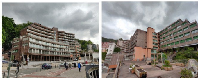
Fig. 1. Caso de estudio del Centro Gerontológico Egogain del municipio de Eibar (Gipuzkoa): (a) Vista desde suroeste (b) Vista desde sureste.
