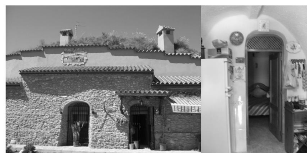
Fig. 1. Detalle de cueva rehabilitada caso de estudio en Cuevas de Almanzora.
