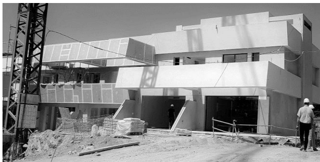
Fig. 1. Vista de sistema de fachada en ejecución (fuente: autores).
