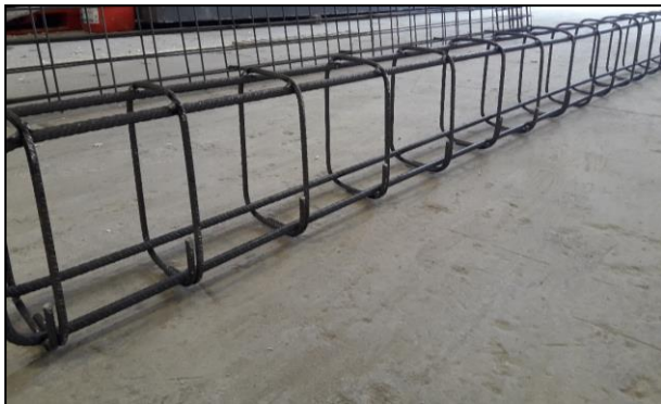
Fig. 3. Armado de viga.
