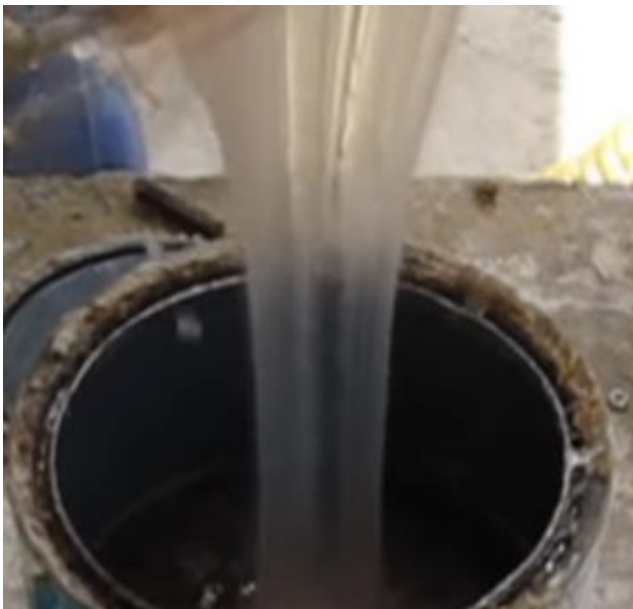
Fig. 6. Preparación de agregado. Elaboración: Torres Francisco, 2019
