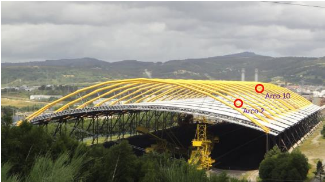
Fig. 3. Cubierta del parque de carbones de la central térmica de As Pontes.
