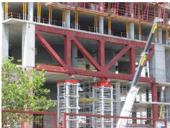
**VIGAS TRIANGULADAS PESADAS Y VIGAS VIERENDELL**
