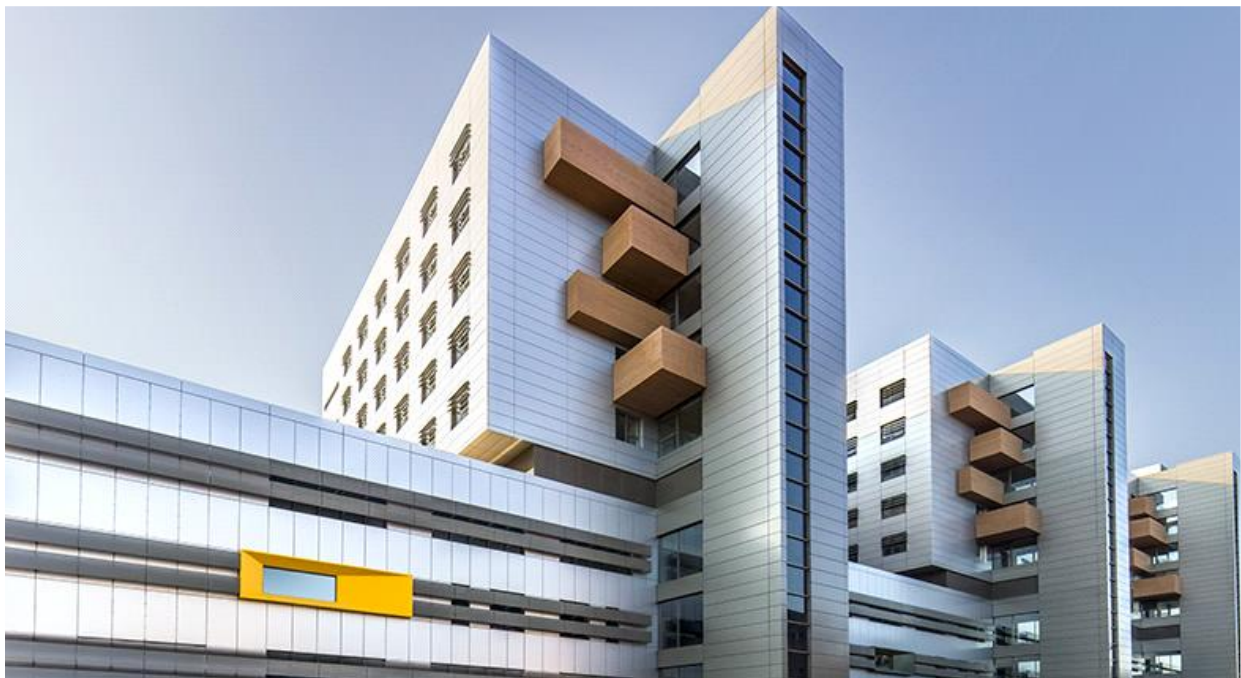
Fig. 9. Ejemplo de ventana desplegada para mostrar información de un PIA ( http://dit.ietcc.csic.es ). Fachada ventilada del Hospital Universitario Marqués de Valdecilla (Santander) revestida con bandejas colgadas y placas remachadas procedentes de paneles compuestos stacbond® y stacbond® FR (DIT 553 P/16)
