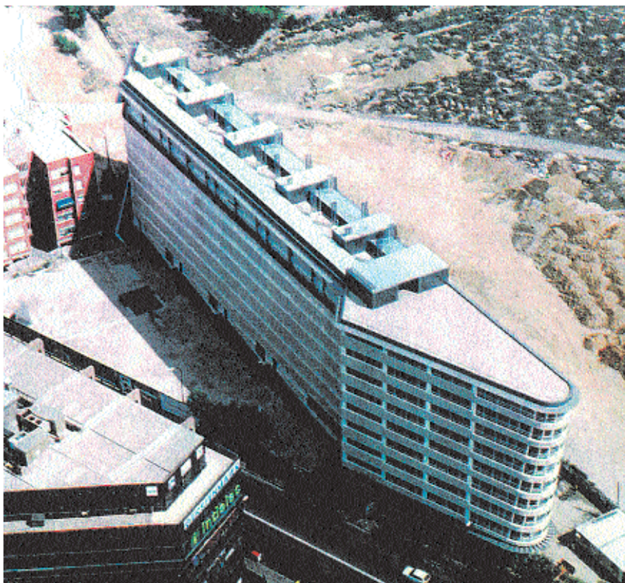
Figura 9: Edificio histórico híbrido de viviendas y oficinas. Arqs. Araujo y Nadal (en Fuencarral).
