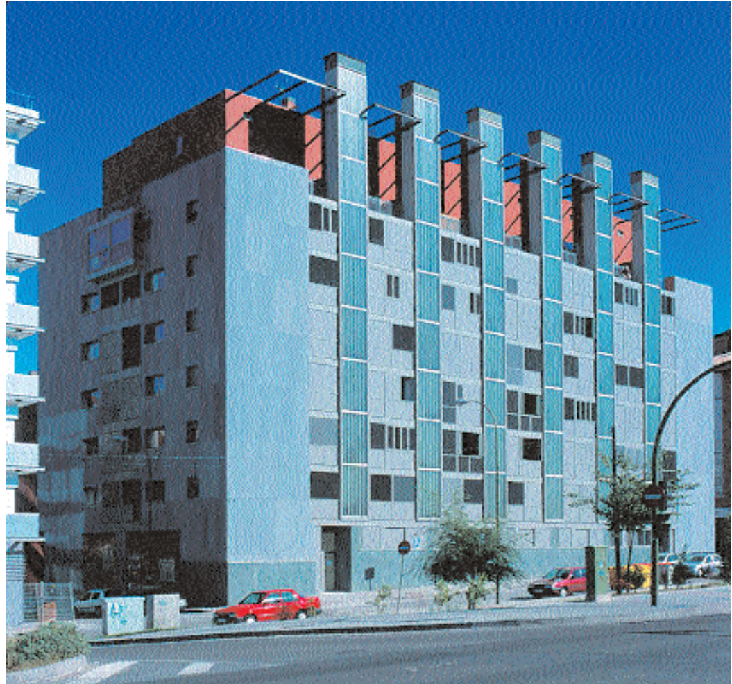
Figura 11: Composición de fachada en la que se emplean las chimeneas de ventilación propias de su arquitectura bioclimática. Arqs. Muelas y Mateo (en la carretera de Andalucía).
