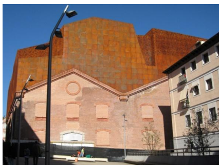
Fig. 03. Paredes ciegas en fachada posterior y laterales. Fuente: Elaboración propia.
