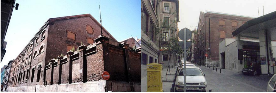
Fig. 01. Antigua Central Eléctrica de Mediodía.
