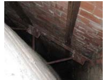
Fig. 7. Recreido de los muros y celosía. Built-up walls and trusses . Fig. 8. Celosía metálica. Steel truss .
