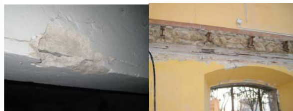
Fig. 15. Viga de la planta de semisótano. Basement beam. Fig. 16. Forjado de pabellón 13. Deck slab in pavilion 13.
