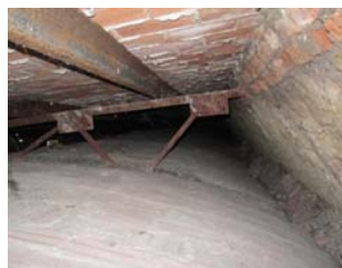
Fig. 9. Bóveda tabicada y celosía. Timbrel vault and steel truss ; Fig. 10. Bóveda tabicada, correas y tablero de cubierta. Timbrel vault, purlins and roof deck .
