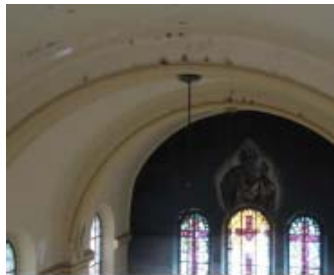
Fig. 5. Cimentación y contrafuertes. Foundations and buttresses . Fig. 6. Arcos fajones. Transverse arches .
