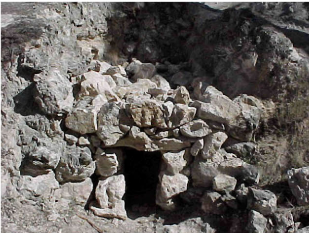
Figura 1. Horno de yeso recién montado en Aguaviva (Teruel). Se puede observar la formación de una bóveda primitiva con piedras de yeso, apoyando sobre el terreno. Las piedras de mayor tamaño y de geometría más favorable para la construcción se colocan en la parte de debajo del horno y en el dintel.
